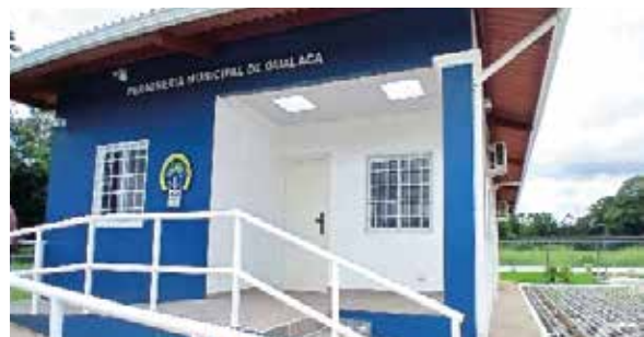
Nueva instalación propia
