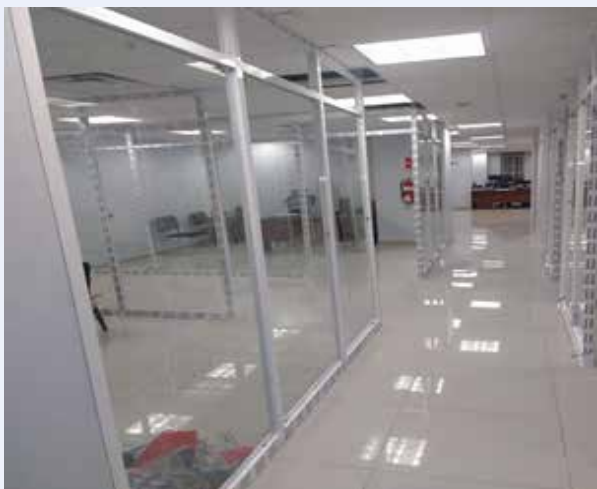
Instalación de Vidrio en Oficinas
