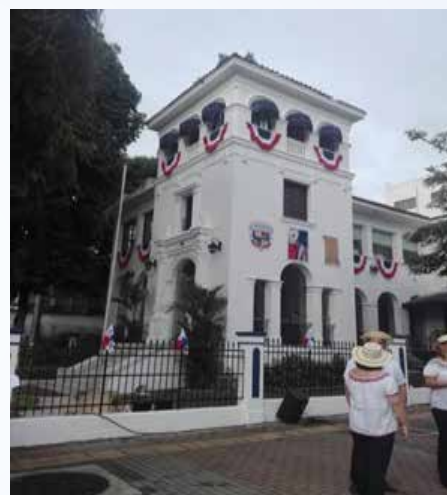
Pintura Externa Casa Porras
